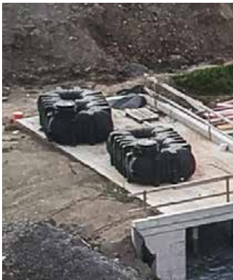
Regenwasserzisterne (zweimal 5.000 l) vor dem Einbau
