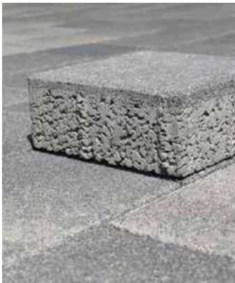
Versickerung auf der gesamten Hof- und Parkfläche
