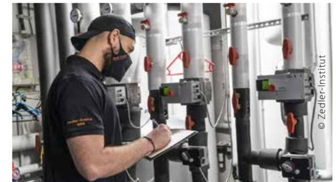
**Monatliches Ablesen** aller Durchflussmengen-zähler, Wärmemessgeräte und Stromzähler
